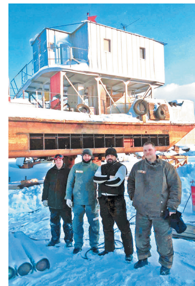
Электросварщики А.Х. Асылбаев, М.М. Енущенко, К.В. Долгопятый, В.Н. Мосейков восстанавливают обшивку «КПЛ-16-30»
