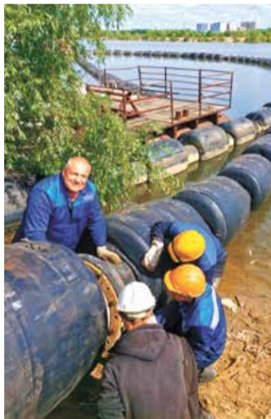
Моторист-матрос В.В. Городко с практикантами занимается сборкой резино-тканевого грунтопровода
