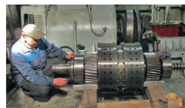
Механик А.В. Денисов ремонтирует главный редуктор з/с «Надым»
