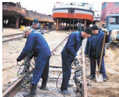
На ремонте горизонтальной части слипа бригада столярно-плотничьего участка З.Р. Аминов и А.Т. Жусупов, рабочий слипа В.М. Макианов и ПП помощник командира «Иртышский -727» В.Н. Исаенко
