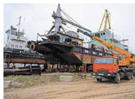
Необходимая для установки часть трубопровода доставлена на землесос автокраном
