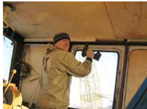
Плотник В.В. Казанцев на монтаже обшивки рубки т/х «Чомга»
