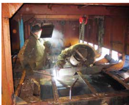
Н.Ю. Ларионов и С.С. Корепанов, монтаж наружной обшивки подводной части «Паром-веранды № 1»
